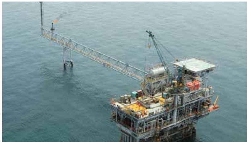
KLA Flowstations, fasilitas lepas pantai PHE ONWJ, yang letaknya berdekatan dengan lokasi penyelamatan kapal nelayan Badak Liar yang mengalami mati mesin
