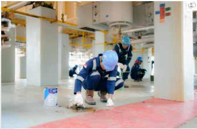
FOTO: YOKI QAMARA SEPTIANA
