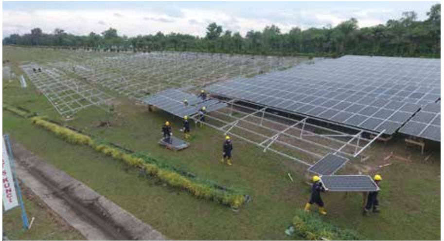
Ilustrasi pemasangan instalasi pembangkit listrik tenaga surya di wilayah operasional Pertamina.
