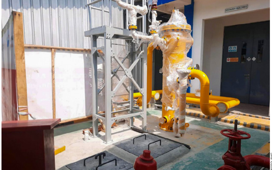
Instalasi scrubber baru yang masih dalam proses pemasangan di offtake Sunyaragi.
